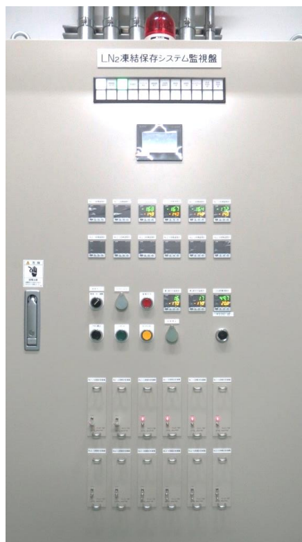
システム集中制御盤
