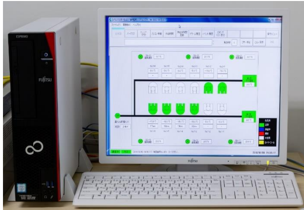
液体窒素保管設備監視システム （品質管理室）
